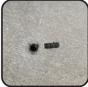
STEP 1 Remove anchor stud
